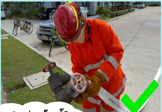
สายดับเพลิงต่อ กับหัว Hydrant แน่นไม่หลุด
