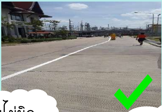
สายดับเพลิงต่อ กับหัว Hydrant แน่นไม่หลุด
