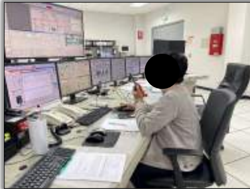
HP Steam Alarm Pressure Low และ MW ลดลง CRO แจ้ง PO ตรวจสอบหน้างาน
